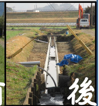
施設の長寿命化(計画①)素掘り水路⇒コンクリート水路
