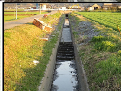
施設の長寿命化 水路補修(底板コンクリート舗装 ※ H27年度へ継続(法面保護)
