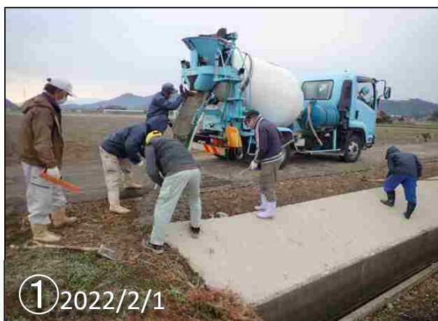
コンクリート補修①
