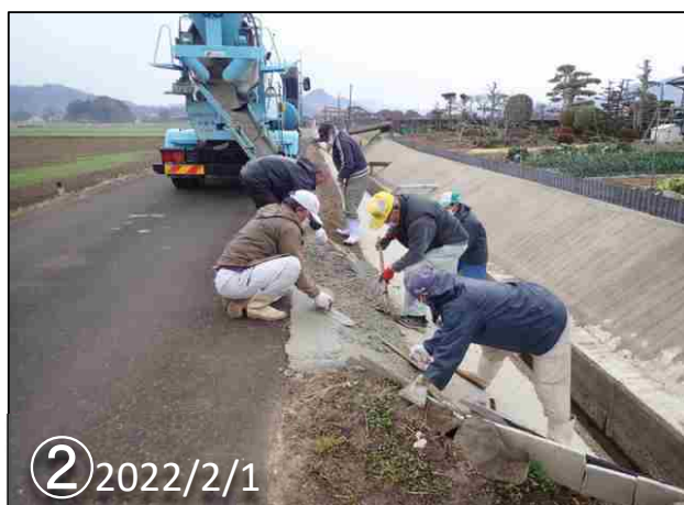
コンクリート補修②
