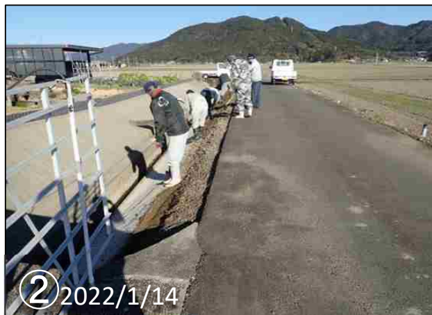
コンクリート補修前の路肩部分整地②
