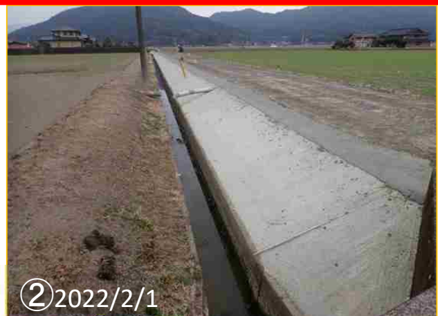
路肩部分コンクリート補修完了
