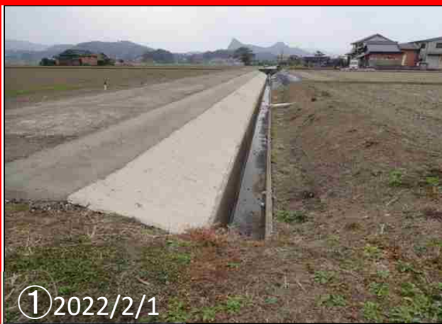
路肩部分コンクリート補修完了
