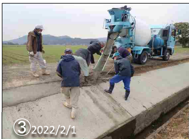
コンクリート補修③
