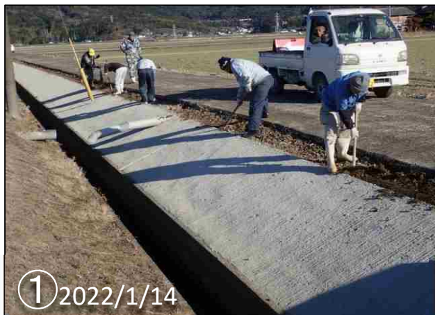
コンクリート補修前の路肩部分整地①
